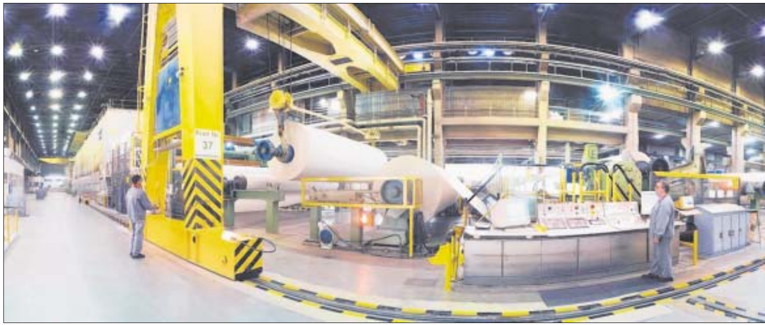
Eine 360-Grad-Ansicht einer Papiermaschine in der rund 300 Meter langen Produktionshalle.
